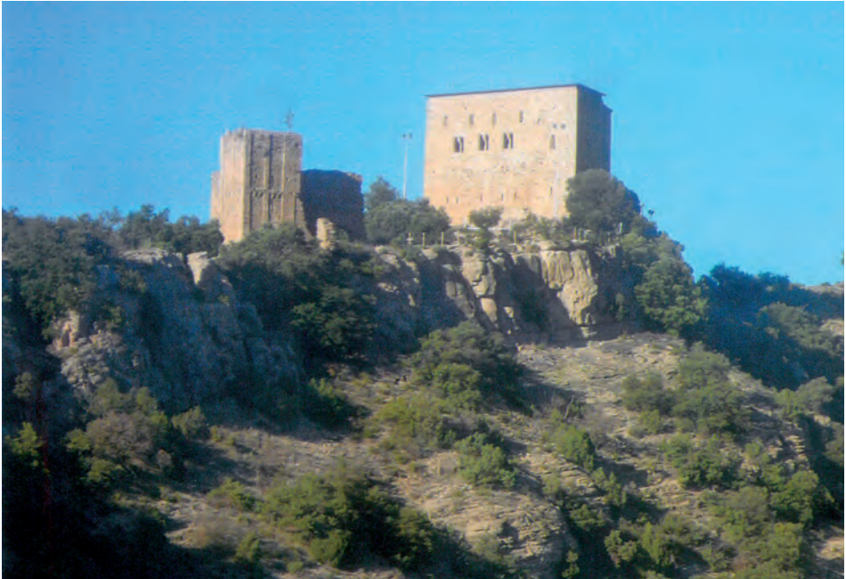
El castell de Llordà ha quedat com el màxim exponent de l'arquitectura romànica civil a Catalunya. (Fotografia: Jordi Mir)
